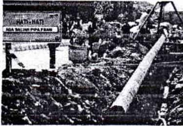
Pipa diturunkan (dalam satuan panjang 24 m) kedalam galian dengan bantuan tackle yang dipasang di tripod. Ilustrasi seperti pada gambar sebelah ini. Setelah itu dilakukan penyambungan antar unit pipa.
